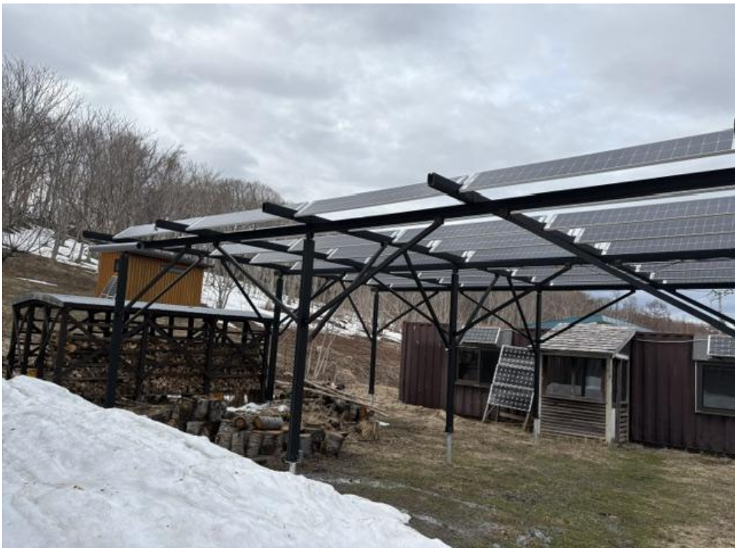
◇エコビレッジの両面ソーラーとタイニーハウス（コンパクトな自給自足型ハウス）
